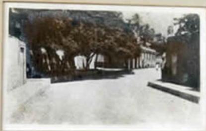
FACHADA DESDE EL ESTE
