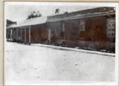
FACHADA DESDE EL OESTE
